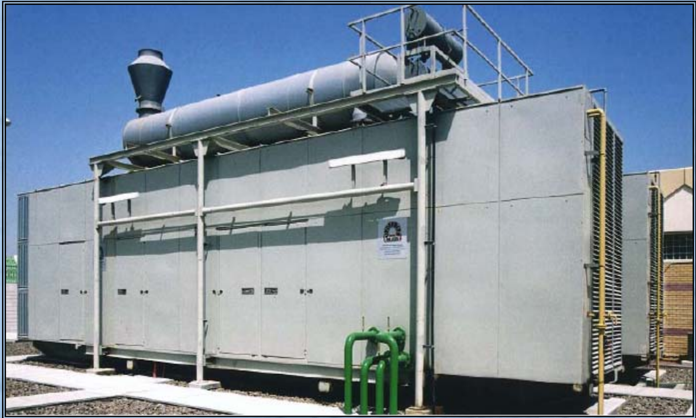
Containerized Module Deutz BV12M 628, 3500 kVA Container (L x B x H : 20 m x 3,5 x 4,5 m, Weight 50 t)
